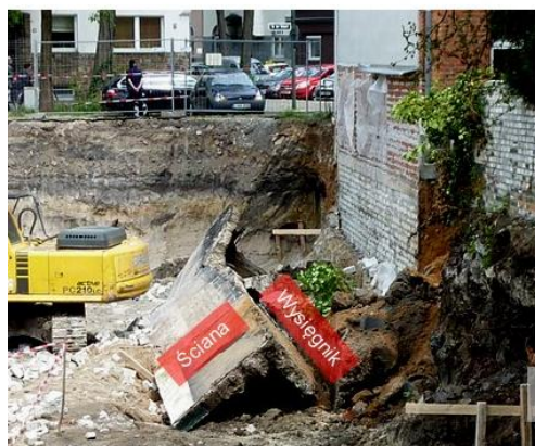
Rys. 4.4. Przebieg wypadku zawalenia się starego stropu piwnicy.
